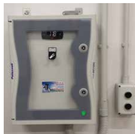
Fig. 1.c - quadro a lato della cella di confezionamento, con controllore iJW
