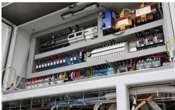
Fig. 1.d - quadro esterno a bordo dell'unità condensante con pRack e driver per il controllo dell'eiettore
